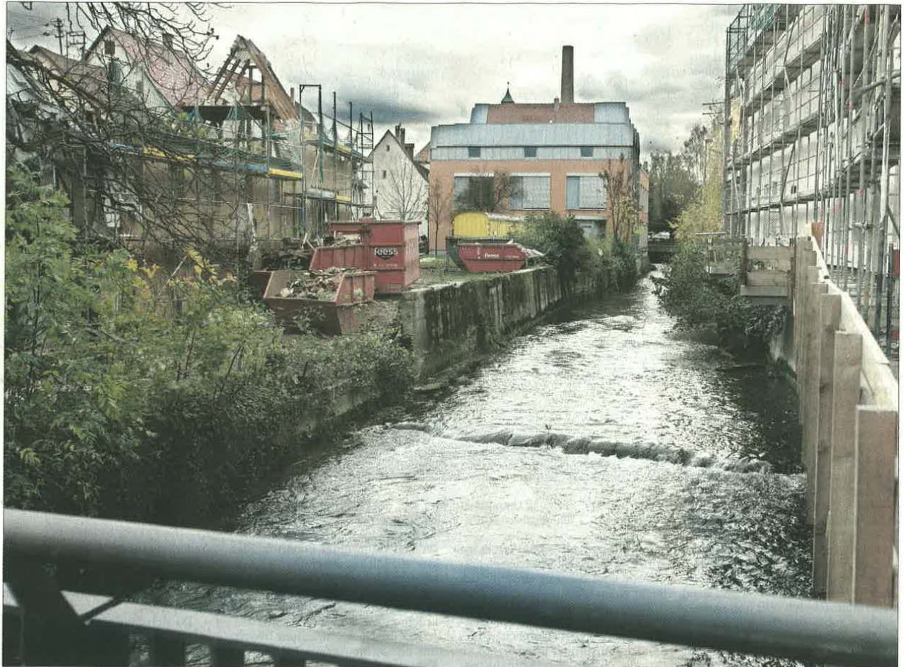
Die Lauter im Betonkorsett: Der Blick von der Max-Eyth-Straße, genauer von der Löwenbrücke, zeigt das Flüsschen im engen Kanal zwischen Schlachthofgelände und Postareal. Doch bald wird die Lauter auch hier befreit. Foto: Jean-Luc Jacques
